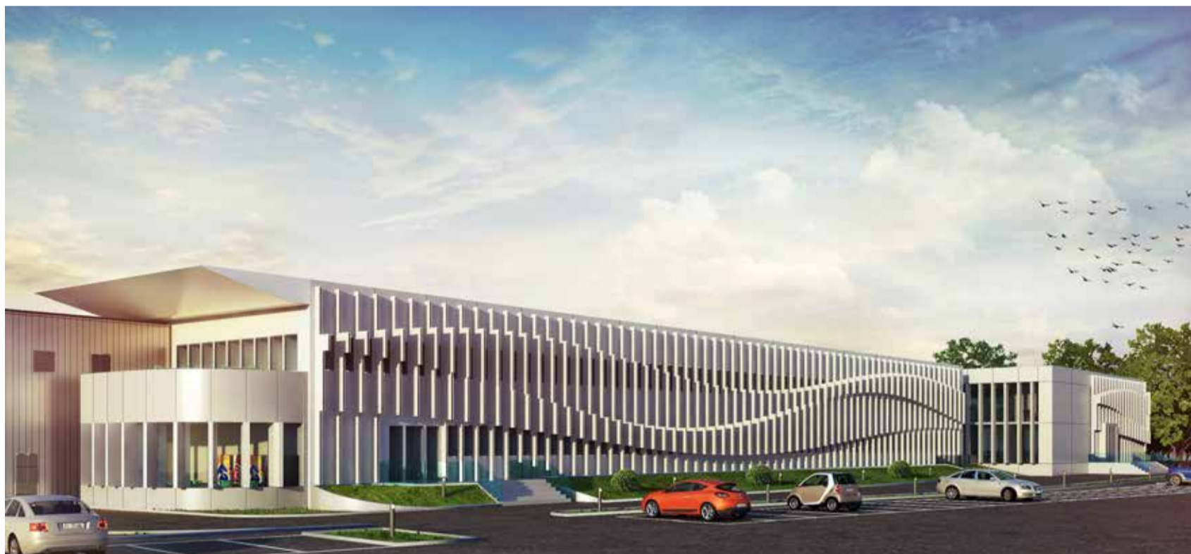
Sew Eurodrive a Solaro, in provincia di Milano, con la nuova facciata caratterizzata da un sistema di ombreggiamento a shades. Tra i progetti campione con il quale Lombardini22 si è approcciata al Bim. Nella fase esecutiva, è stato creato un file General Warehouse di catalogazione di tutte le informazioni relative agli elementi del progetto.
